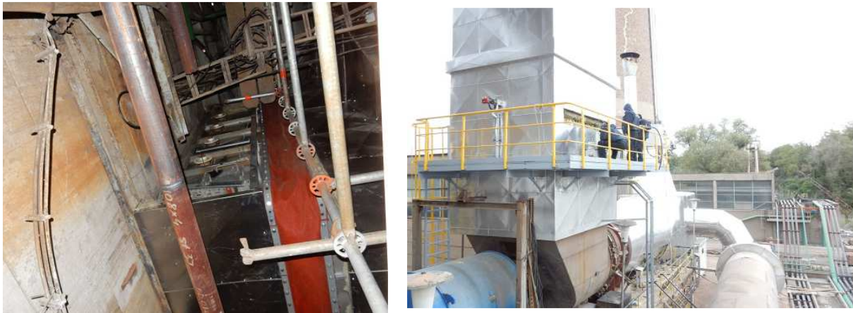
Слика 2. Фотографије мерних места за мерење концентрације прашкастих материја у димном гасу испред (лево) и иза (десно) ЕФ на десном каналу димног гаса
